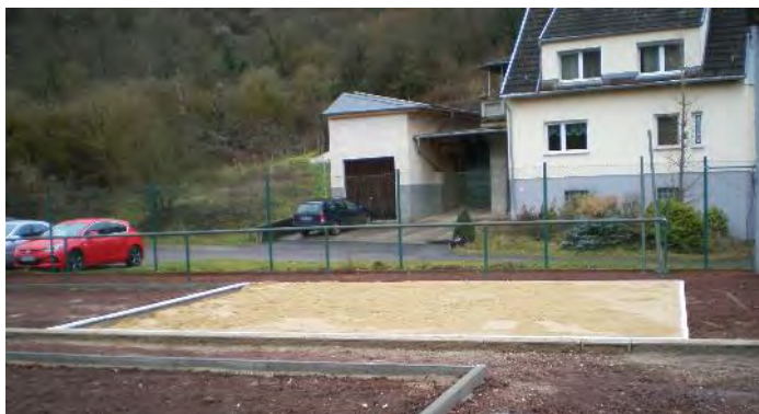
Die Sprunggrube ist bereits mit Sand gefüllt
